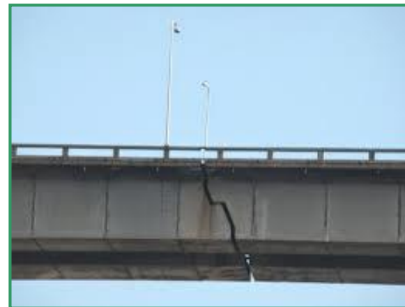
Junta de dilatação na ponte Rio-Niteroi
