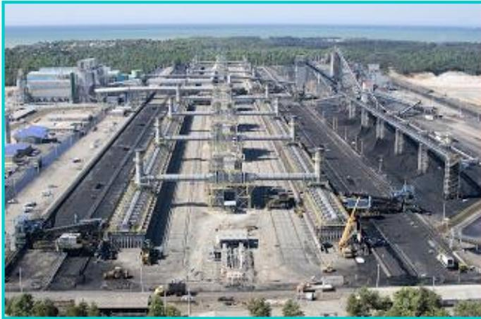
Coqueria é a unidade industrial que transforma a mistura de carvões minerais em coque. O coque metalúrgico é empregado nos altos fornos como combustível, redutor, fornecedor de carbono ao gusa e permeabilizador da carga. O processo de coqueificação (destilação do carvão mineral) foi descoberto na Inglaterra no século XVIII.
