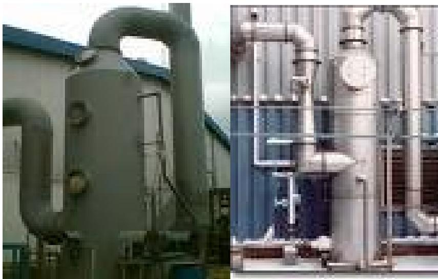
**Figura 10** – Torre ou coluna absorvedora (Scrubber)
