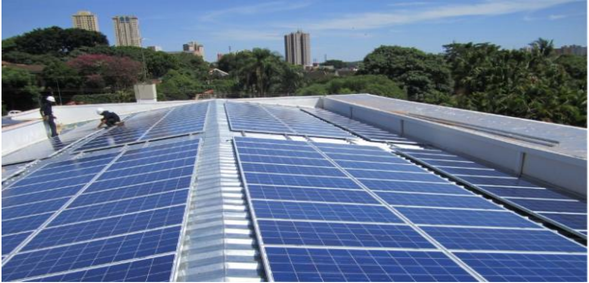
Figura 4 - Instalação de painéis fotovoltaicos no telhado de um estabelecimento
