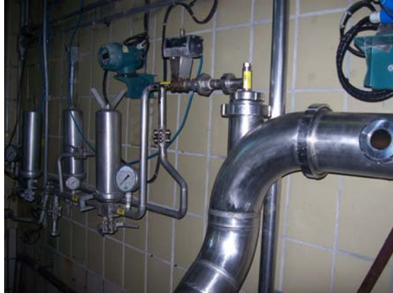
Figura 7: Sistema de aeração convencional.
