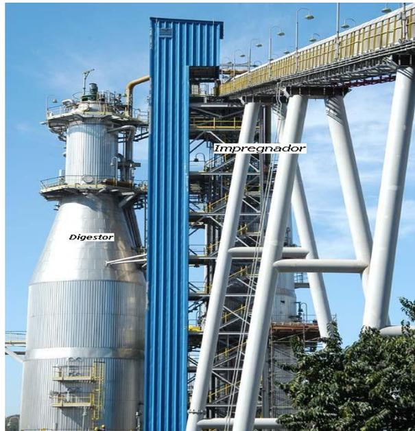
**Figura 3-** Ilustração de um Digestor
