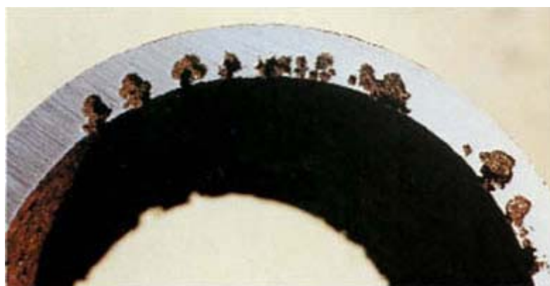
FIGURA 16: FOTOGRAFIA DO CORTE TRANSVERSAL DE UM TUBO DE AÇO CARBONO, MOSTRANDO A PENETRAÇÃO ATINGIDA PELOS PITTINGS 8 .
