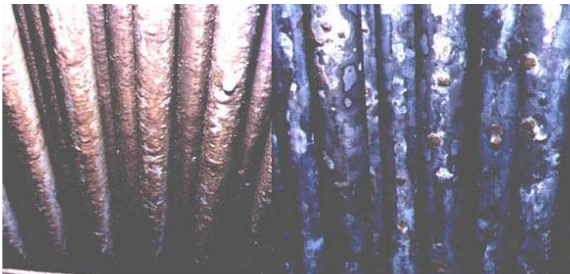
FIGURA 12: (ESQ.): TUBOS INCRUSTADOS DE UM CONDENSADOR EVAPORATIVO. (DIR.): TUBOS DO MESMO EQUIPAMENTO APÓS, LIMPEZA QUÍMICA.
