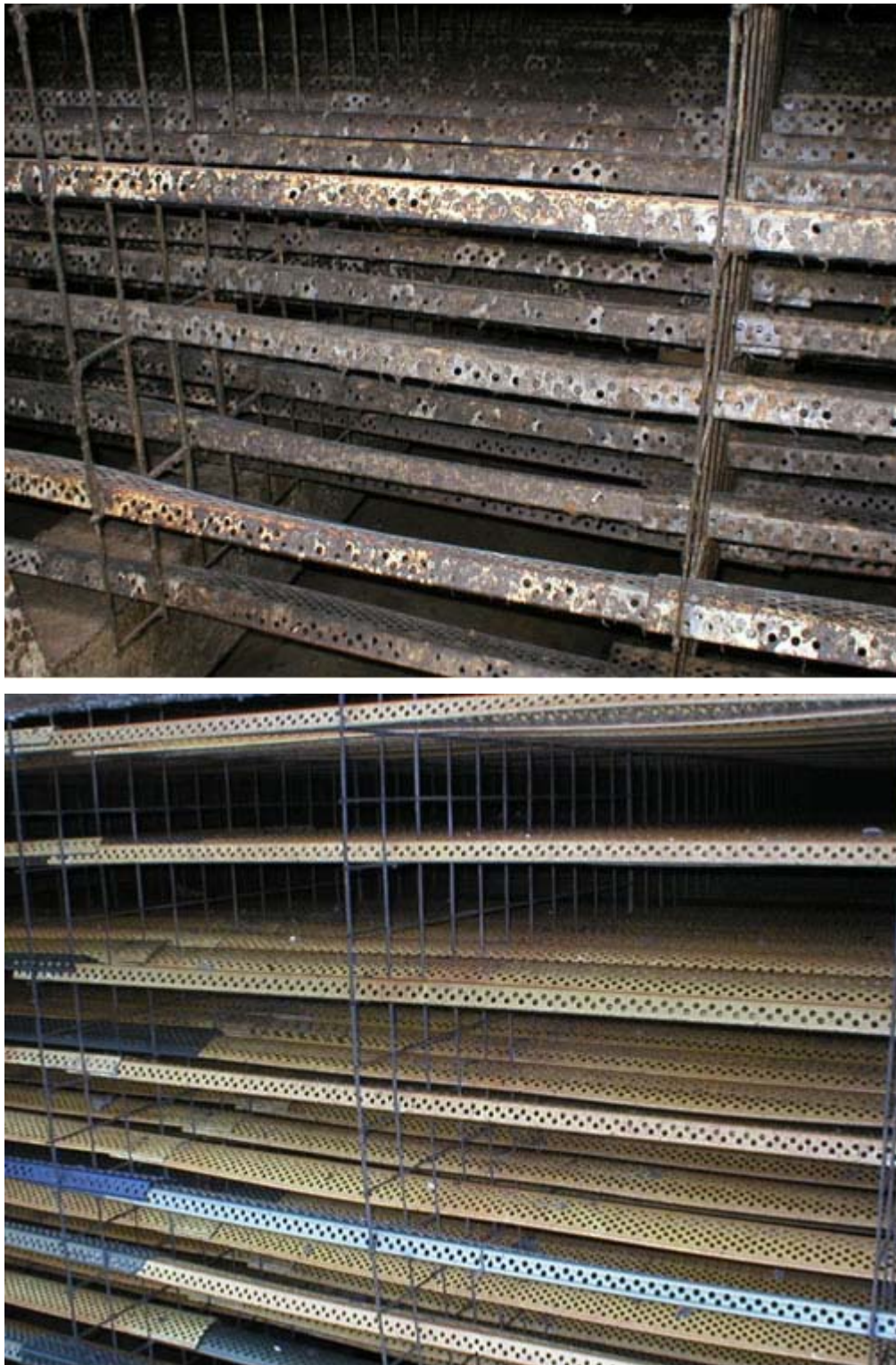
FIGURA 25: EM CIMA: ENCHIMENTO DE TORRE DE RESFRIAMENTO (CANALETA EM "U INVERTIDO" PERFURADA), MOSTRANDO O DESENVOLVIMENTO DE BIOFILME. COMPARAR COM A CANALETA LIMPA (ABAIXO).
