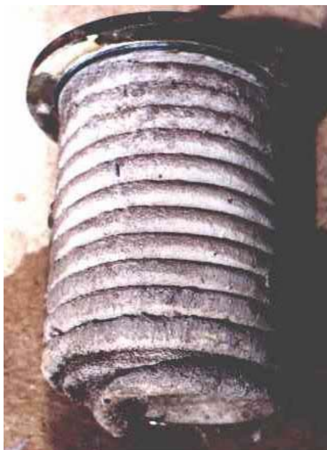
FIGURA 13: RESFRIADOR DE ÓLEO DE UM COMPRESSOR QUE SOFREU PROCESSO INTENSO DE DEPOSIÇÃO/ INCRUSTAÇÃO PELA ÁGUA DE RESFRIAMENTO.
