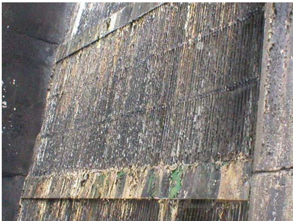
FIGURA 26: SEPARADOR DE ARRASTE (VENEZIANAS) DE UMA TORRE DE RESFRIAMENTO DE FLUXO CRUZADO, MOSTRANDO OCORRÊNCIA DE ARRASTE PROVENIENTE DO EXCESSO DE MATERIAL ORGÂNICO NA ÁGUA.
