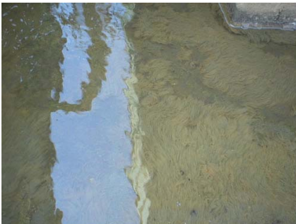
FIGURA 22: CRESCIMENTO EXAGERADO DE ALGAS NO FUNDO DA BACIA DE UMA TORRE DE RESFRIAMENTO, EXPOSTA À LUZ SOLAR.
