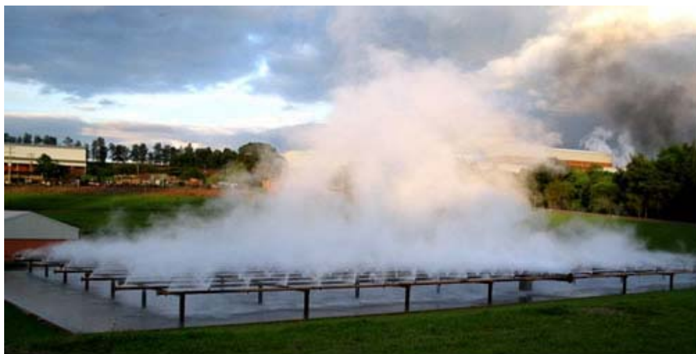
FIGURA 04: SISTEMA DE RESFRIAMENTO DO TIPO "SPRAY-POND".
