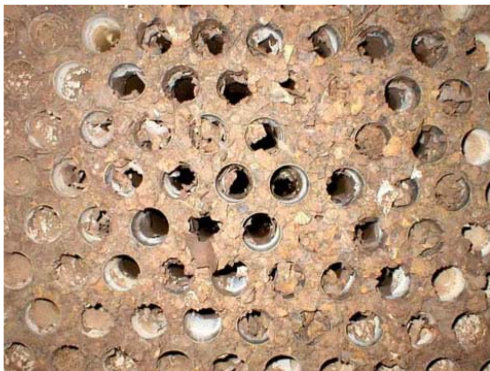
FIGURA 24: TROCADOR DE CALOR TIPO CASCO E TUBOS (CONDENSADOR, LADO ÁGUA) MOSTRANDO MATERIAL ORGÂNICO PROVENIENTE DE DESENVOLVIMENTO MICROBIOLÓGICO, DEPOSITADO NO INTERIOR DOS TUBOS.
