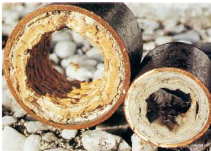
FIGURA 11: INCRUSTAÇÕES DE CARBONATO DE CÁLCIO FORMADAS NO LADO ÁGUA: (ESQ.): EM UM CONDENSADOR. (DIR.): EM UM TROCADOR DE CALOR COM TUBOS DE COBRE.
