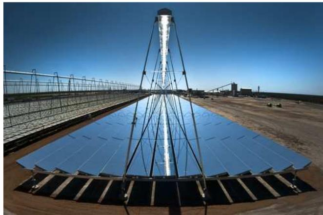
Figura 14 – Refletor Linear de Fresnel AREVA Solar.
