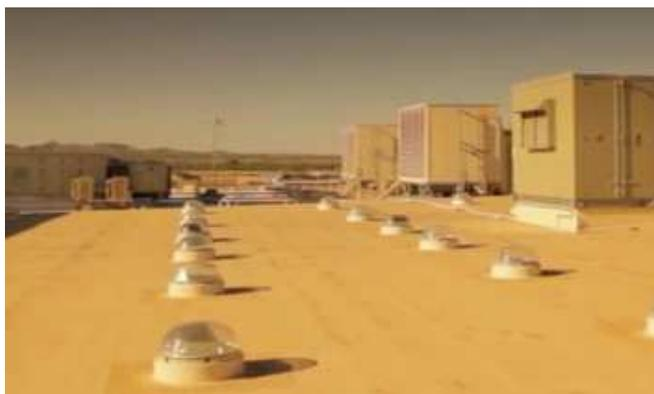
Figura 41 – Fotografia do sistema de aproveitamento de energia solar passiva na planta Frito-Lay, Casa Grande.
